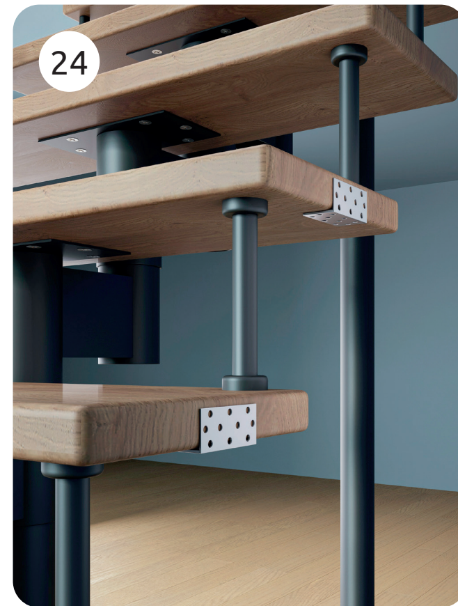
24. Дополнительно фиксируем ступени и площадки уголками к стене, для снятия нагрузки на край ступеней и площадок.
