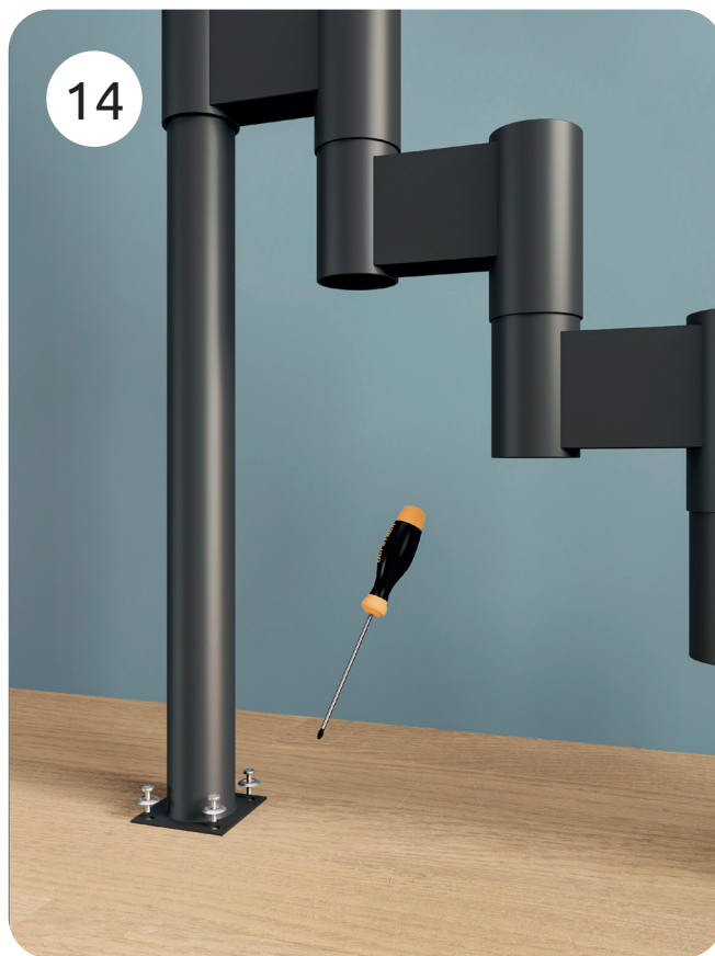
14. Фиксируем опоры к полу.
