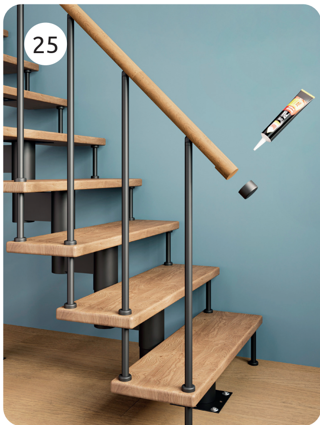
25. Фиксируем наконечники на перила клеем (жидкие гвозди).
