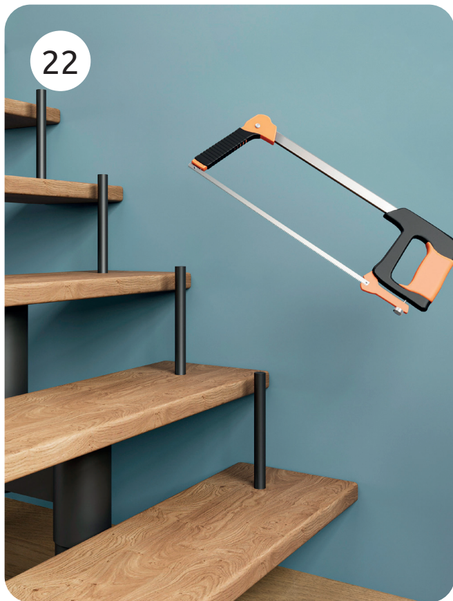
22. Подпиливаем больца под необходимую высоту между ступенями в распор.
