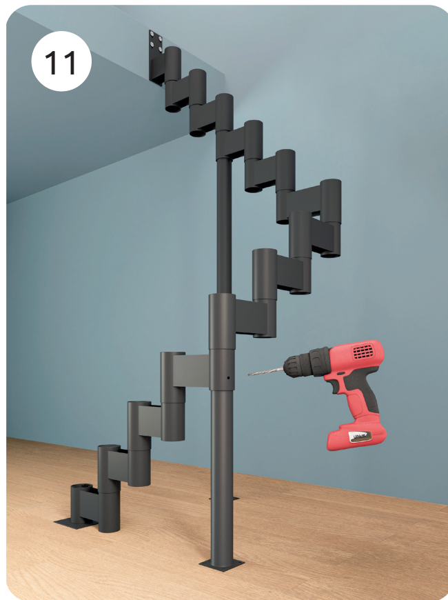
11. Для установки подпорки сверлим отверстие в модуле и опоре для фиксации между собой либо используем саморезы.
